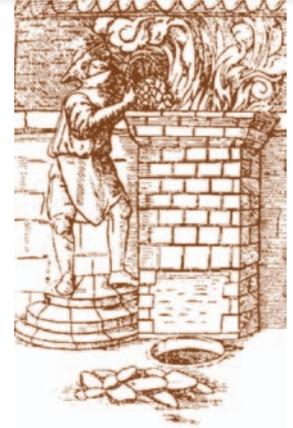
Progressivement, le bas foyer recevra un parement de pierres réfractaires, puis un tronc en cône sera ajouté, émergeant à peine, avant de déborder nettement au-dessus du sol, dans un second temps. Au cours du XIV<sup>e</sup> siècle, le soufflage hydraulique de l'air dans les fours de réduction du minerai permet d'agrandir les dimensions du bas foyer.
