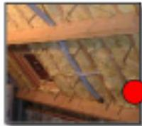
Isolation de laine de roche réalisée sur le rampant.
