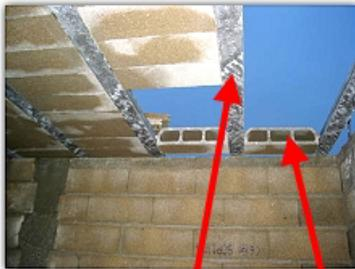
Entre chaque poutre, on pose des hourdis 7. Ce sont des briques de ciment ou de terre cuite qui sont posées à cheval entre 2 poutres
