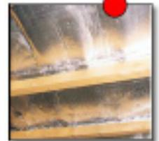
Matériaux composite alternant une couche métallisée et un moleton synthétique. Ce sont les ITR, les isolants thermiques par réflexion
