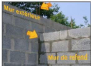
Le mur de refend, n'est pas une cloison, mais un mur construit et encastré dans les murs extérieurs.
