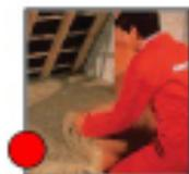
Isolation de laine de roche réalisée sur plancher sous les combles
