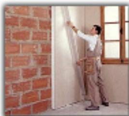
Pose d'une contre-cloison en panneaux alvéolaires
