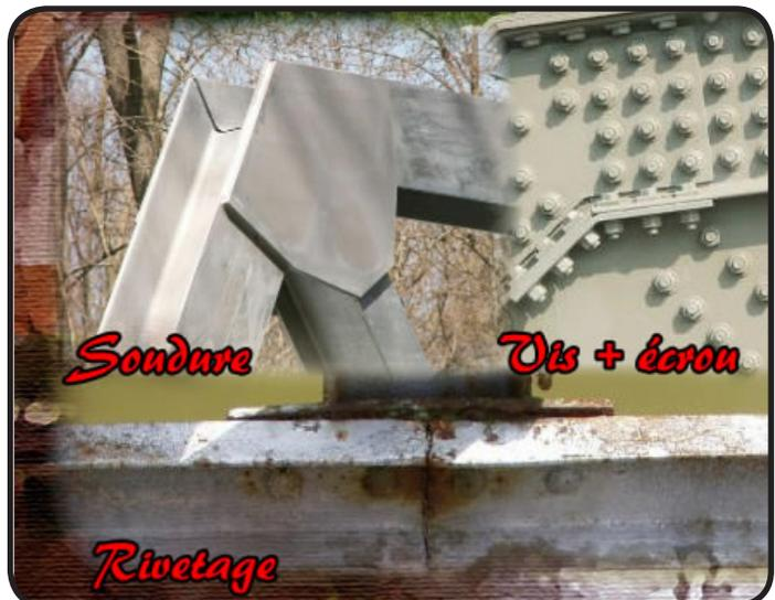
Autres types d'assemblages de poutres pour les ponts métalliques:
