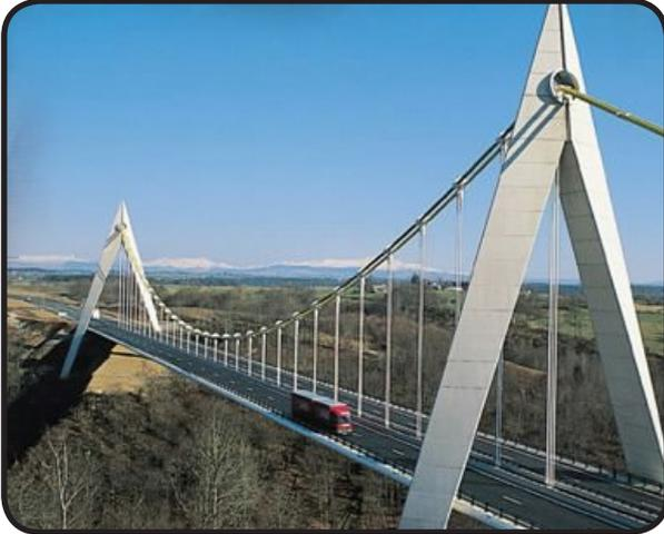
Un pont suspendu est un pont dont la structure est supportée par un ensemble de **pylônes** et de câbles torsadés.
