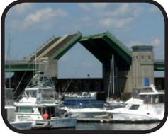
Les **ponts levants** peuvent s'apparenter à une porte sur laquelle on circule.
