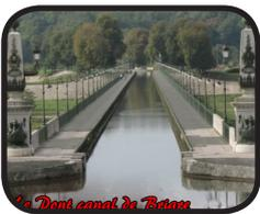
Un **pont-canal** est un pont qui permet à un cours d'eau navigable, généralement un canal, de franchir un obstacle en creux, une vallée ou un vallon le plus souvent. Un autre usage du pont-canal est l'accès par l'amont à un ascenseur à bateaux.
