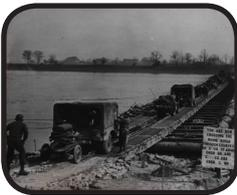
Les **ponts flottants**, ou ponts de bateaux peuvent être provisoires ou fixes. Ils ont l'avantage de pouvoir être mis en place très rapidement, c'est pourquoi cette technique est très utilisée par l'armée.
