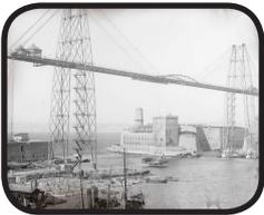
Un **pont transbordeur** est un pont enjambant un port, un canal ou un fleuve, pour faire passer les véhicules et les personnes d'une rive à l'autre dans une nacelle suspendue à un chariot roulant sous le tablier.
