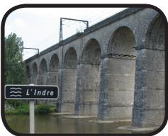
Le **viaduc** est un pont un peu particulier : il présente une hauteur ou longueur beaucoup plus grande que nécessaire à la traversée. Il a été conçu ainsi pour permettre aux routes et plus tard aux voies ferrées de traverser des vallées ou des régions montagneuses, sans avoir à creuser de tunnels ou couper une colline, un massif.
