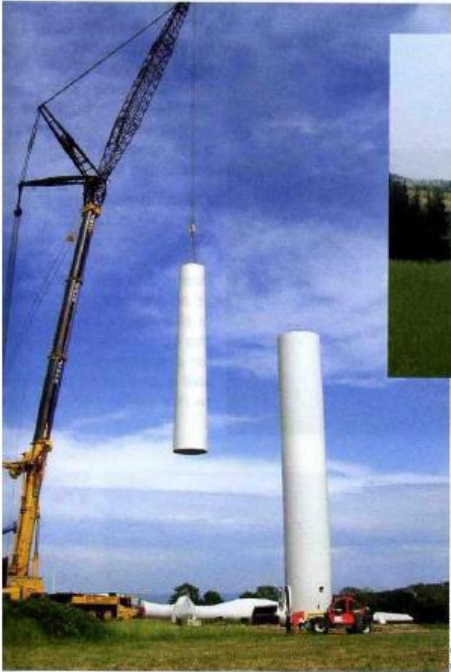
La grue télescopique 500 t, aidée par un système "superlift" met en place le mât intermédiaire. L'éolienne est en tout composée de quatre tronçons de mât The 500-tonne telescopic crane, aided by a "superlift" system, sets up the intermediate mast. The wind generator consists of four mast sections in all
