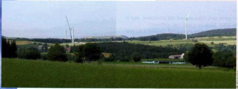
La grue télescopique 500 t, aidée par un système "superlift" met en place le mât intermédiaire. L'éolienne est en tout composée de quatre tronçons de mât The 500-tonne telescopic crane, aided by a "superlift" system, sets up the intermediate mast. The wind generator consists of four mast sections in all
